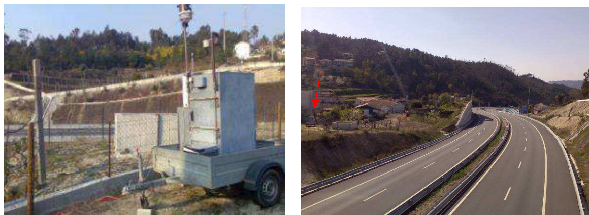
Figura 5.1 – Perspectiva da estação móvel de qualidade do ar durante as medições realizadas no local de medição P1 – Rua Bouça – Km de obra 1+630 – Padronelo.
